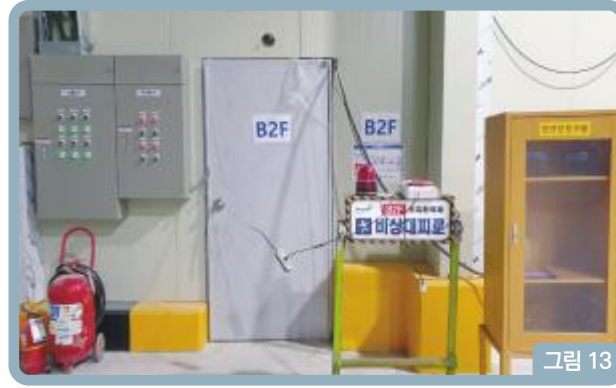
[그림 13] 비상경보장치 미작동 상태
