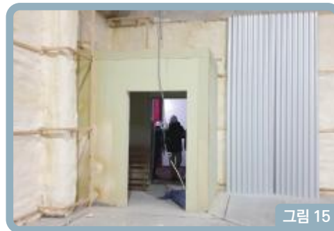
[그림 15] 계단 출입구 간이피난유도선 미설치
